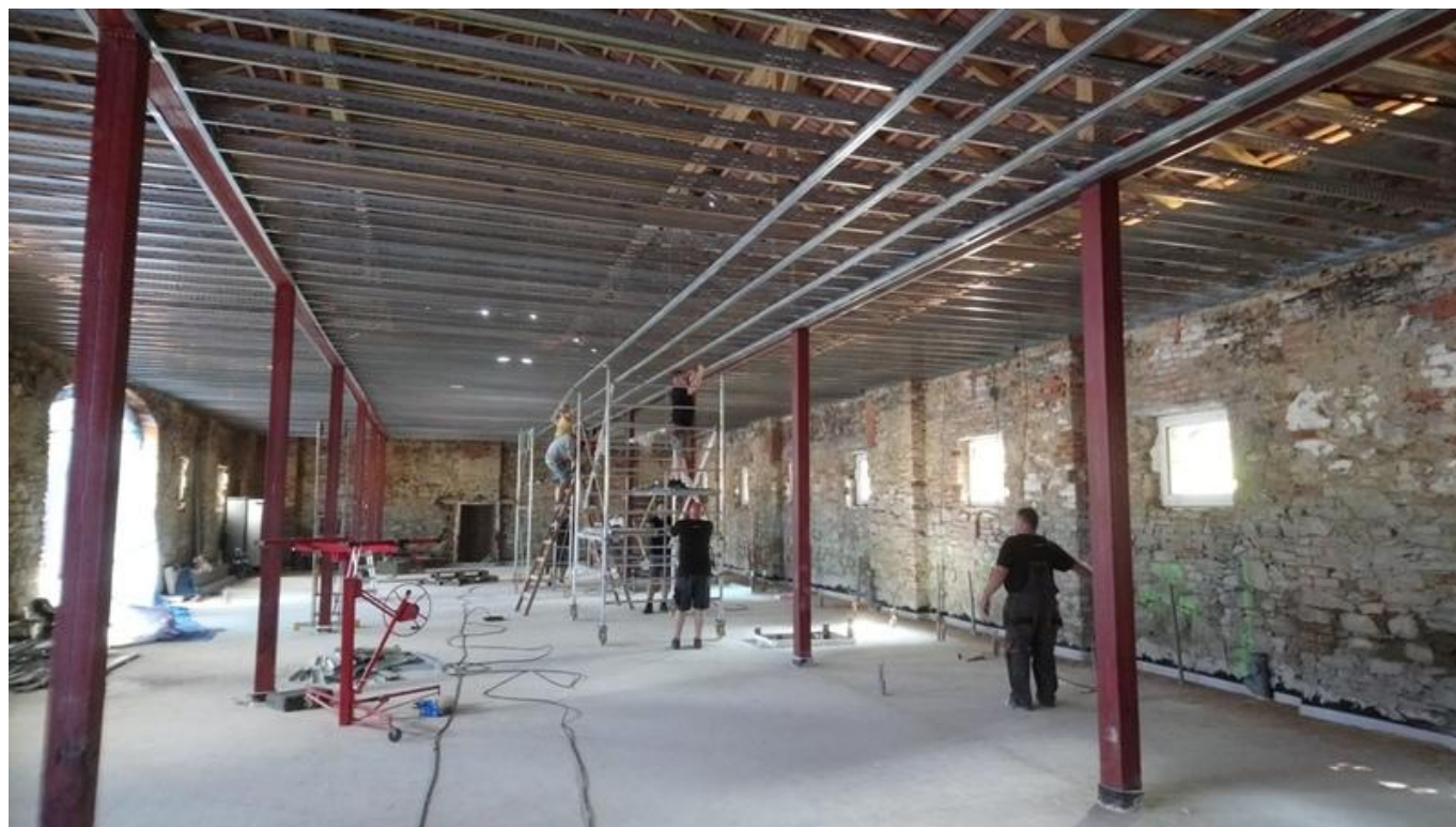
[15] Průběh prací při rekonstrukci
