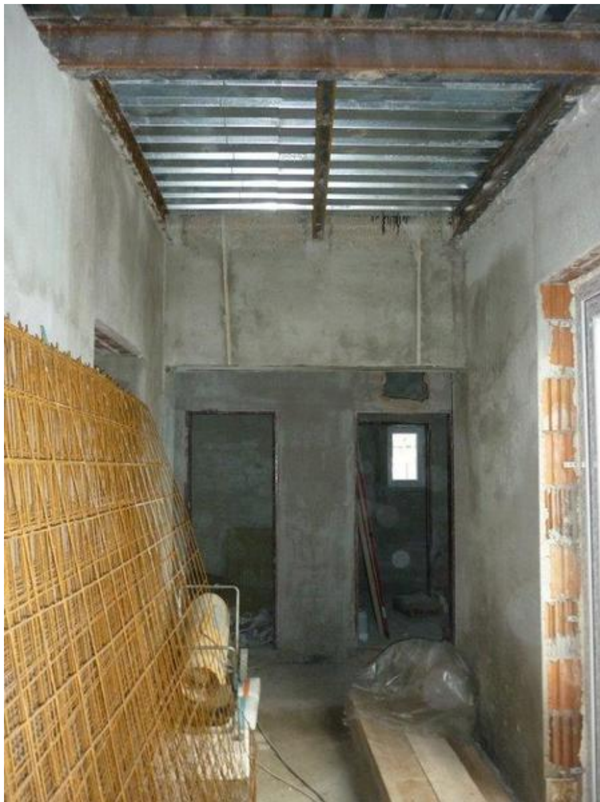
Z rekonstrukce (14. prosince 2015)
